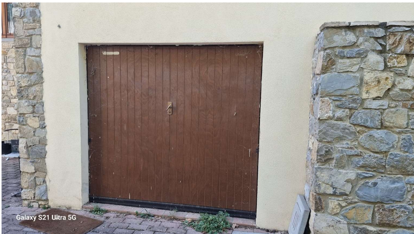
Garage – Ingresso garage
